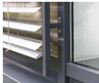
Führungsschiene mit Abstandhalter
